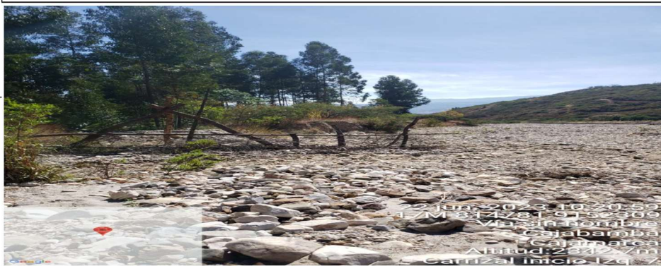
FIGURA N°03: SE VISUALIZA ESPIGONES (GALLINERO) RUSTICOS DE MADERA INSTALADO PARA EVITAR QUE DURANTE LAS MAXIMAS AVENIDAS ARRASE CON SUS CULTIVOS, LOS MISMOS QUE NO SON FUNCIONALES.
